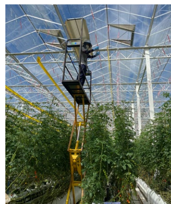
高所作業に使用する昇降台車。
