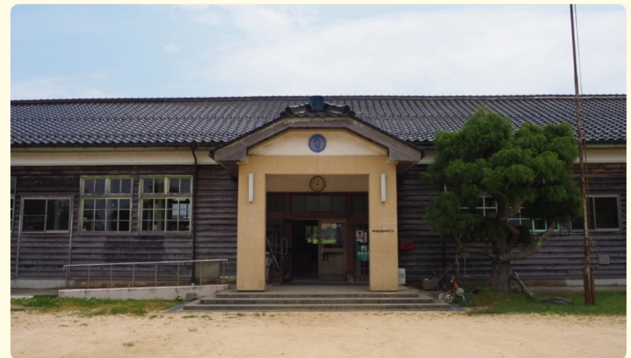
1954（昭和29）年に建て替えられた木造校舎
