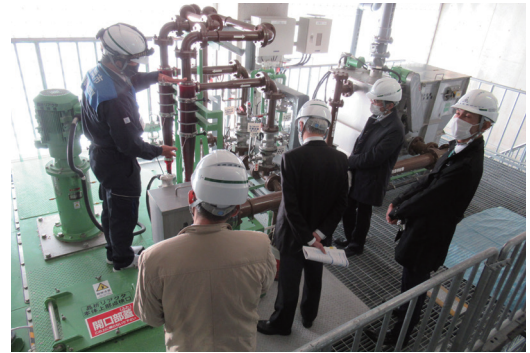
和白水処理センターでは最新の「MAP分離装置」を導入。再生リンの回収量が大幅に増えた。
