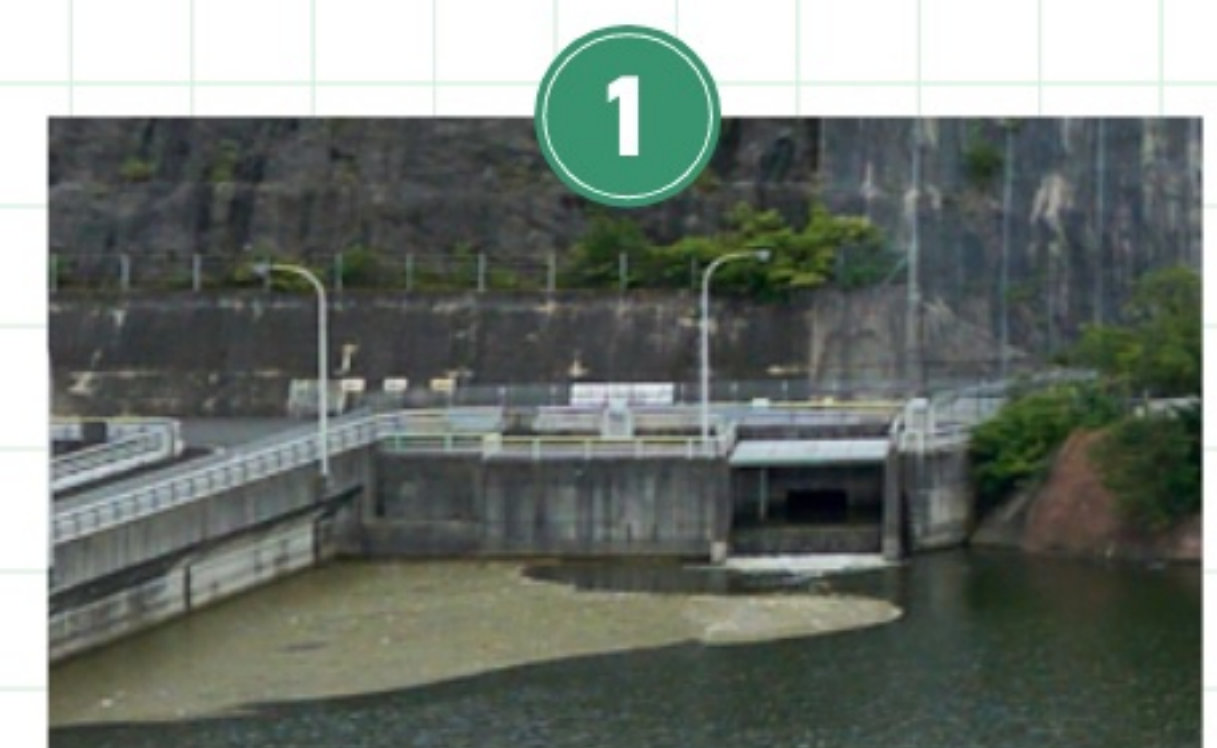
大川瀬導水路注入口 大川瀬ダムから送水された水の出口
