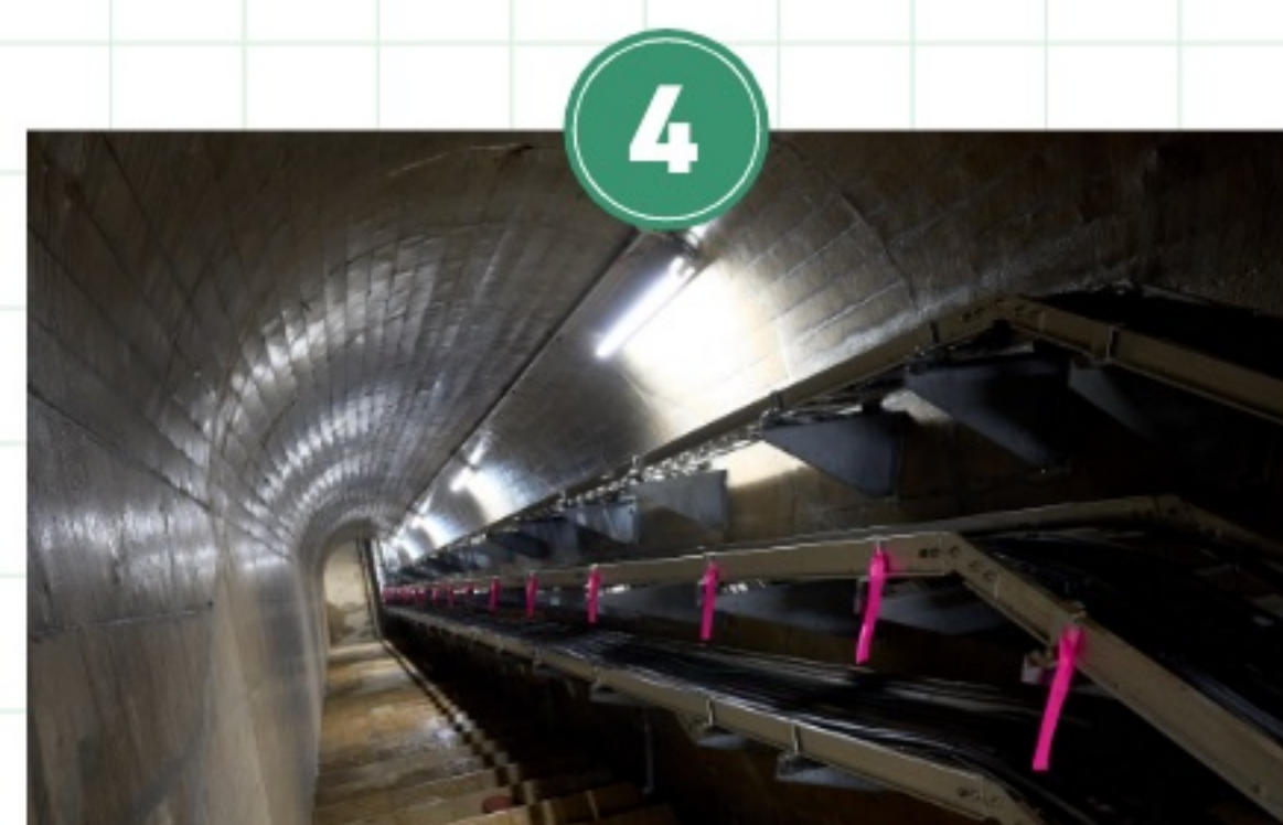
監査廊 ダムの堤体内部にある、ひび割れや漏水などの異常の有無の観察・測定などの点検を行う管理用通路
