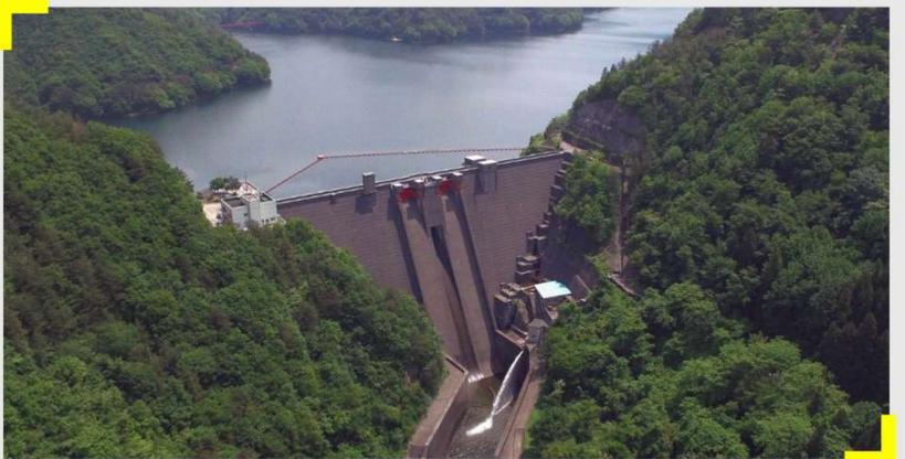
日本国内に13しかない中空重力式コンクリートダム。新発田市を中心に、越後平野北部の加治川沿いに広がる約6,100ヘクタールの耕地に用水補給を行っています。内部の空洞を利用して毎年秋にコンサートが開催されています。
