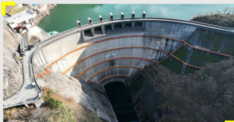
小矢部川上流にある、農林水産省が建設した最初のドーム型アーチ式コンクリートダムです。ダム下部には円錐状のコーンとスリーブ（筒）を組み合わせた「ハウエルバンガーバルブ」が設置されていて、雪解け時には迫力のある放流が見られます。
