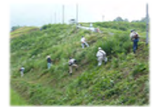
法面の共同草刈り作業
