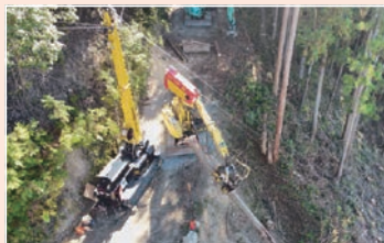
▲主伐現場で稼働する 先進林業機械
