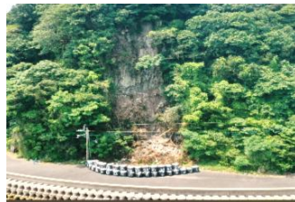
山腹崩壊による土砂流出
