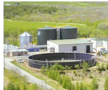
バイオガス発電所
