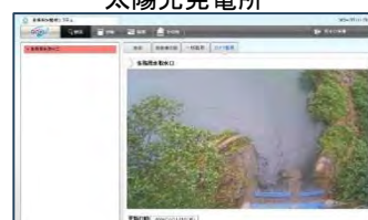
用水施設管理のIT化 (取水口遠隔監視システム)
