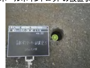
マーカローケーティングシステムの設置状況
