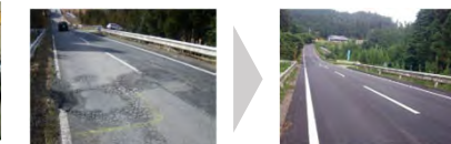
路面改良を実施した農道
