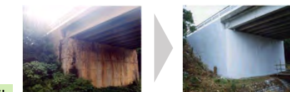
老朽化対策を実施した農道橋
