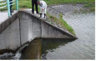
農業用ため池の低水位管理
