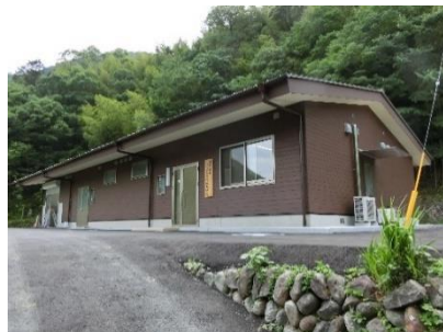
<西米良村ジビエ処理加工施設>
