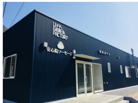
<宇佐ジビエファクトリーの処理施設>
