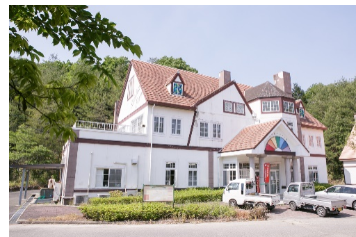
＜処理施設が入る建物の外観＞
