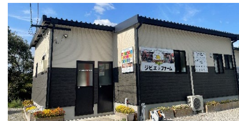
＜処理施設の外観＞
