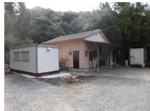
＜処理施設の外観＞
