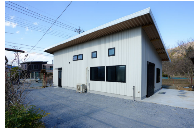
<処理施設の外観>
