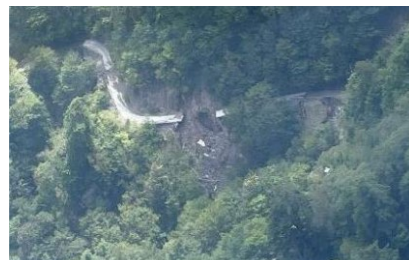
国有林の被災状況
