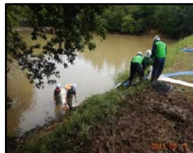
【排水ポンプによる技術支援】
