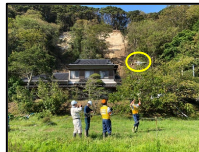
【ドローンによる現地調査】
