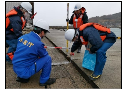
【漁港被害調査】
