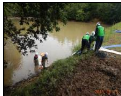
【排水ポンプによる技術支援】
