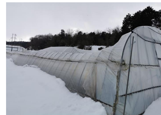
農業用ハウスの損壊
