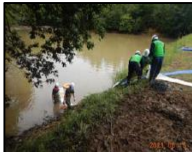
【排水ポンプによる技術支援】
