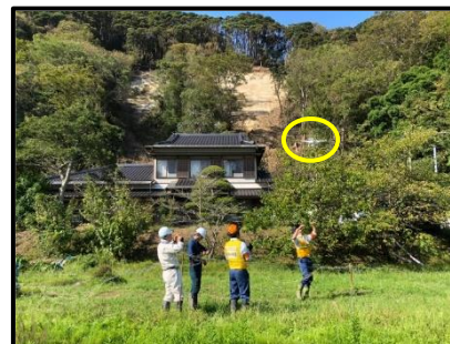
【ドローンによる現地調査】
