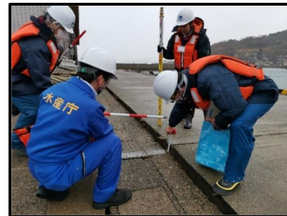
【漁港被害調査】
