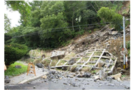
応急仮工事の事例 (仮設防護柵の設置)
