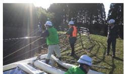
被災ため池の水位低下のためのポンプ排水
