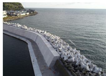
越波を防ぐための防波堤の高上げ
