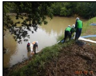
【排水ポンプによる技術支援】
