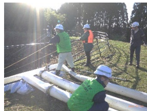
ため池における排水ポンプの設置
