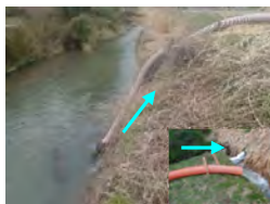
仮設ポンプ設置（珠洲市）
