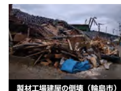
製材工場建屋の倒壊（輪島市）
