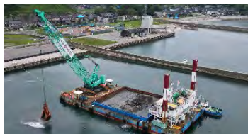
狼煙漁港における浚渫工事
