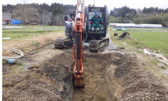
<パイプライン修繕工事（能登町）>
