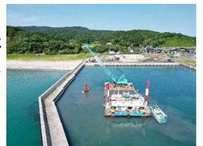
狼煙漁港における浚渫工事（珠洲市、6月）
