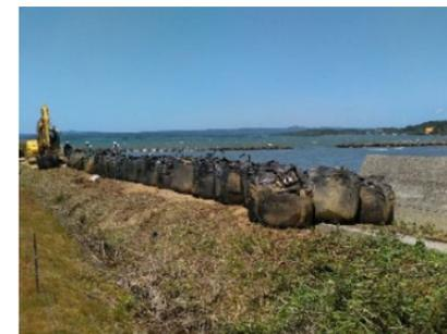
大型土のう設置（農地海岸）（七尾市）
