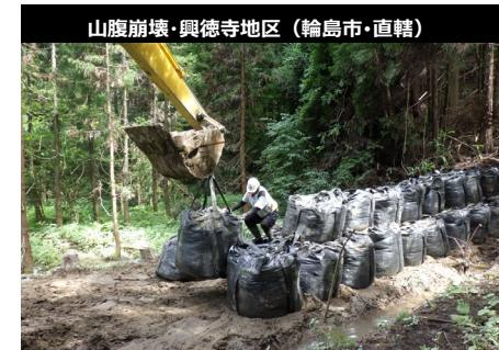
大型土のう設置（山腹崩壊の応急工事）（輪島市）
