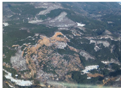
大規模な山腹崩壊
