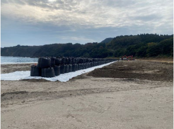
狼煙漁港における復旧工事（珠洲市,11月）
