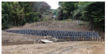
応急対策完了（大型土のう設置） （珠洲市）
