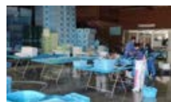
修復した荷さばき施設（輪島市 R7年1月）
