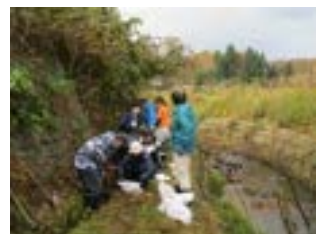
共同活動による土砂撤去
