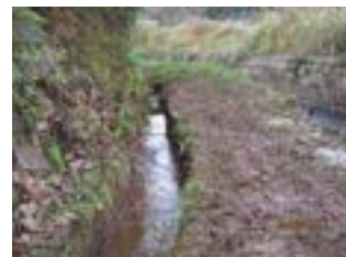
土砂撤去完了
