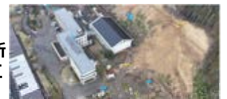
小学校裏山での本復旧工事（珠洲市）
