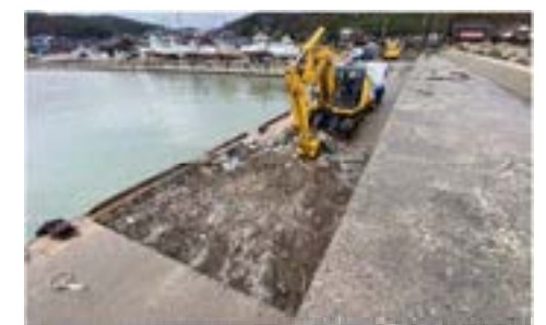
狼煙漁港における復旧工事（珠洲市 R7年1月）
