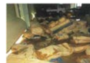
農業倉庫の堆積土砂等の除去
