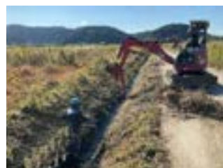
機械による水路の土砂撤去
