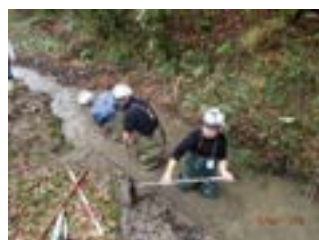
人力による水路の土砂撤去
