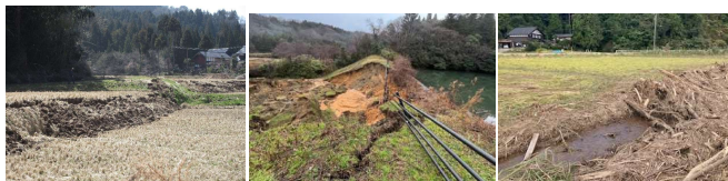
農地に生じた大きな段差（1月の地震） ため池の被害（1月の地震） 農地への土砂・流木の流入（9月の豪雨）
