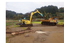
農地の堆積土砂・流木の撤去
