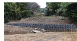
山腹崩壊の応急対策完了（大型土のう設置）
