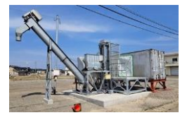
修復した砕氷貯氷施設
