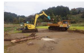
農地の堆積土砂・流木の撤去
