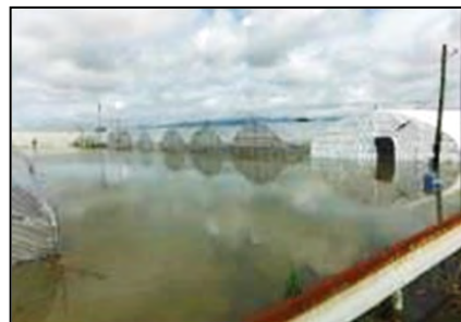
浸水被害を受けたハウス
