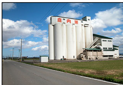
農林水産物処理加工施設 （ライスセンター）
