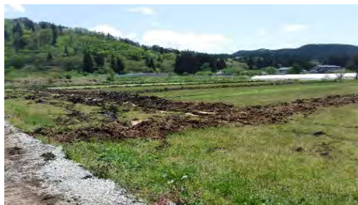
作付け開始前に暗渠排水を施工
