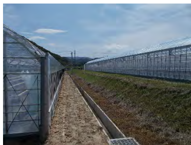
明渠排水対策
