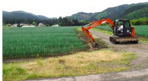
排水のための明渠掘削
