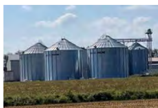
4,500tの貯蔵が可能な貯蔵施設
