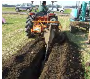
暗渠排水の整備
