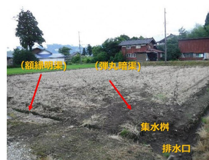
排水対策(集水樹+弾丸暗渠+額縁明渠)の施工
