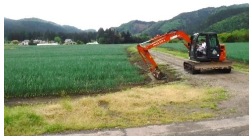
排水のための明渠掘削
