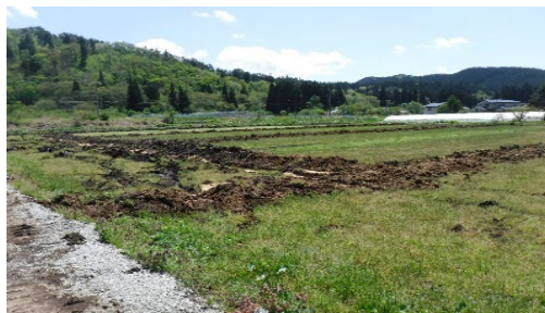
作付け開始前に暗渠排水を施工
