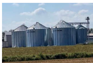
4,500tの貯蔵が可能な貯蔵施設
