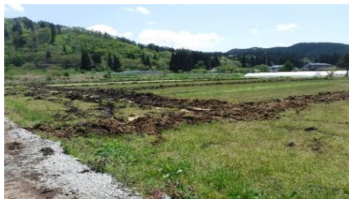
作付け開始前に暗渠排水を施工
