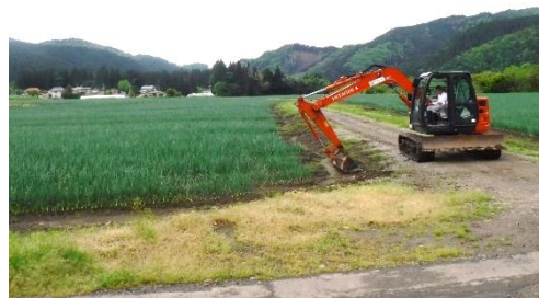
排水のための明渠掘削
