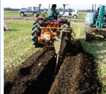
暗渠排水の整備
