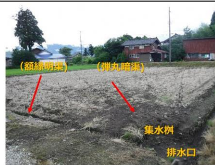
排水対策(集水柵+弾丸暗渠+額縁明渠)の施工
