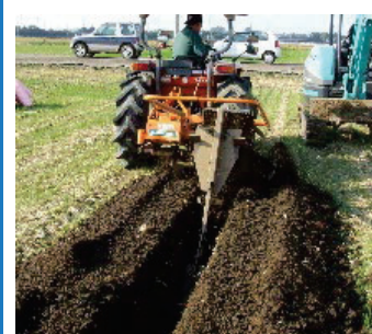
暗渠排水の整備
