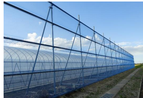
防風ネットの設置
