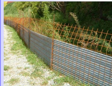
↑ 「忍び返し」の施工例(滋賀県日野町)
