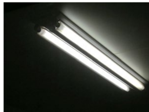
図 3 蛍光灯カバーによる飛散防止
