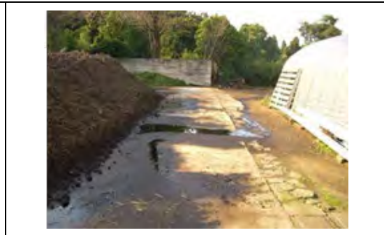
図3 堆肥の廃汁流出 (提供：富山県)
