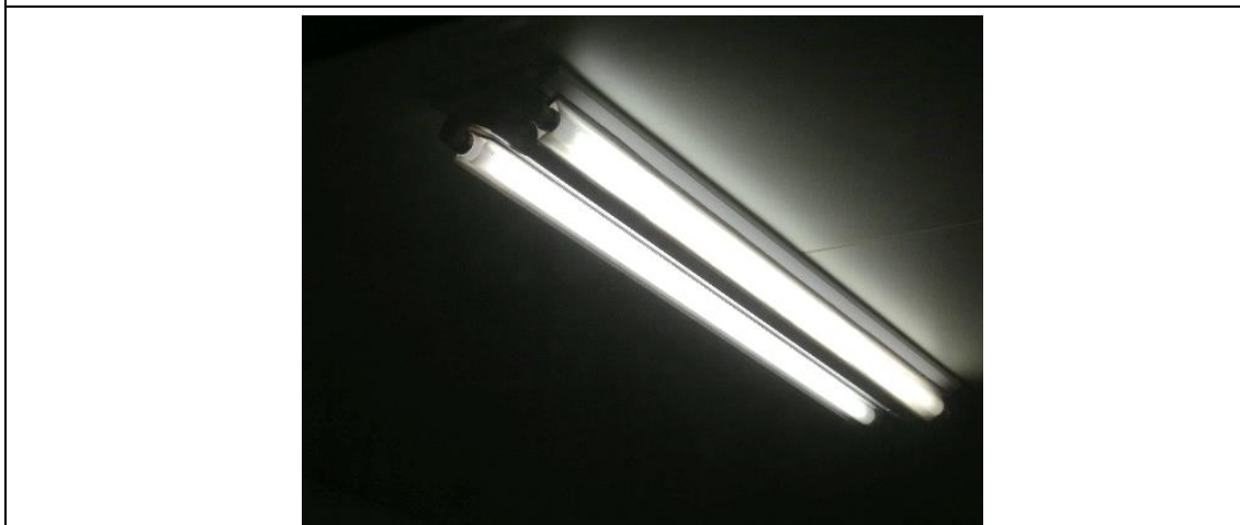
図3 蛍光灯カバーによる飛散防止
