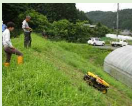
リモコン草刈り機による除草作業
